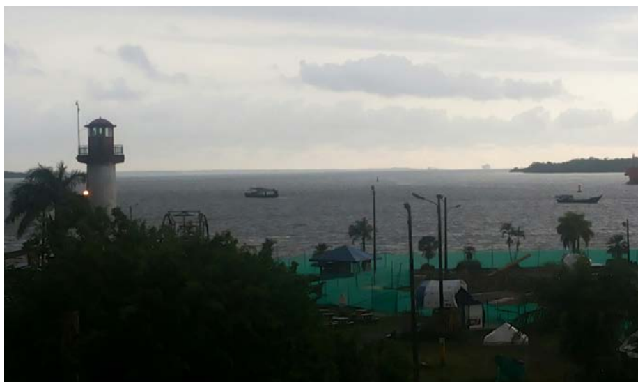
Visión panorámica de la primera etapa de la construcción del Malecón Bahía de la Cruz, ubicado en la Isla Cascajal. Fotografía: Erika Parrado
